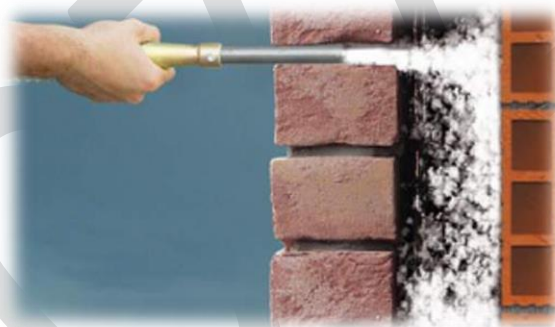
Figura 4-22: Insufflaggio delle pareti verticali.
